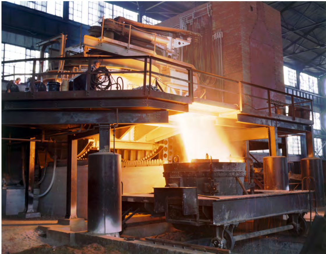
Abbildung 9.1: Abstich an einem 35-Tonnen Elektrolichtbogenofen, Allegheny Ludlum Steel, 1943.
